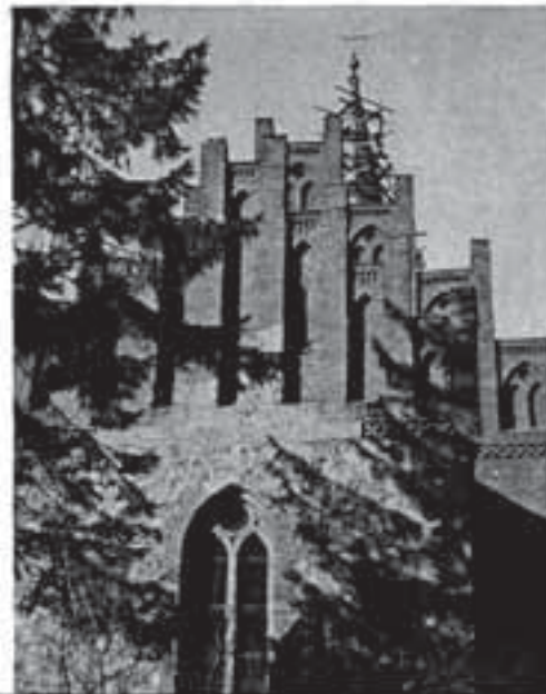
Reparaturarbeiten am Turm Anfang der 80er Jahre
