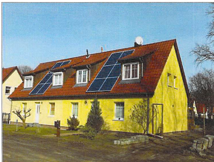
Beispiel 5: Solarmodule auf einer Dachfläche mit Gauben (Simulation)
