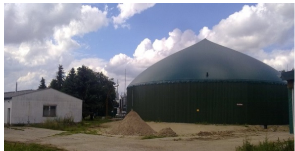
Windpark, Photovoltaikanlage auf dem Flugplatz, Biogasanlage
