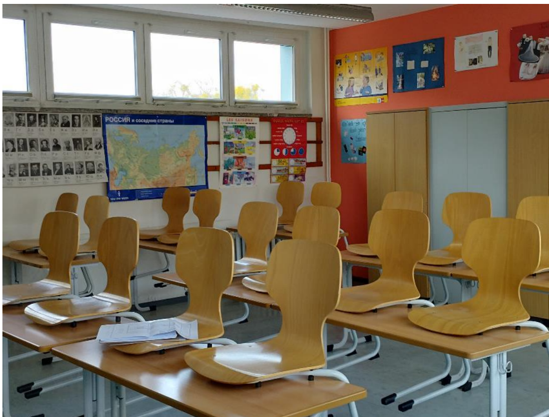
Abb. 4: Die Klassenräume sind teilweise deutlich zu klein dimensioniert.
