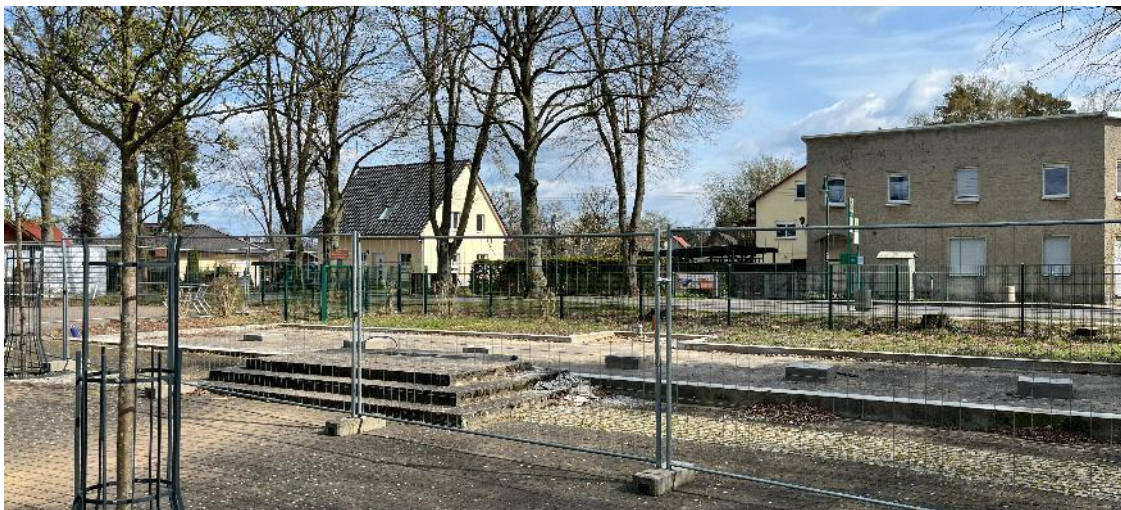
Abb. 9: Der Stellplatz für den Schulcontainer wurde bereits vorbereitet.
