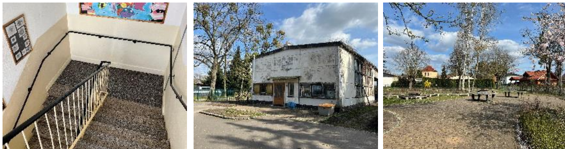
Abb. 2: Treppengeländer im Schulgebäude, ehemaliges Heizhaus, Schulhofgelände
