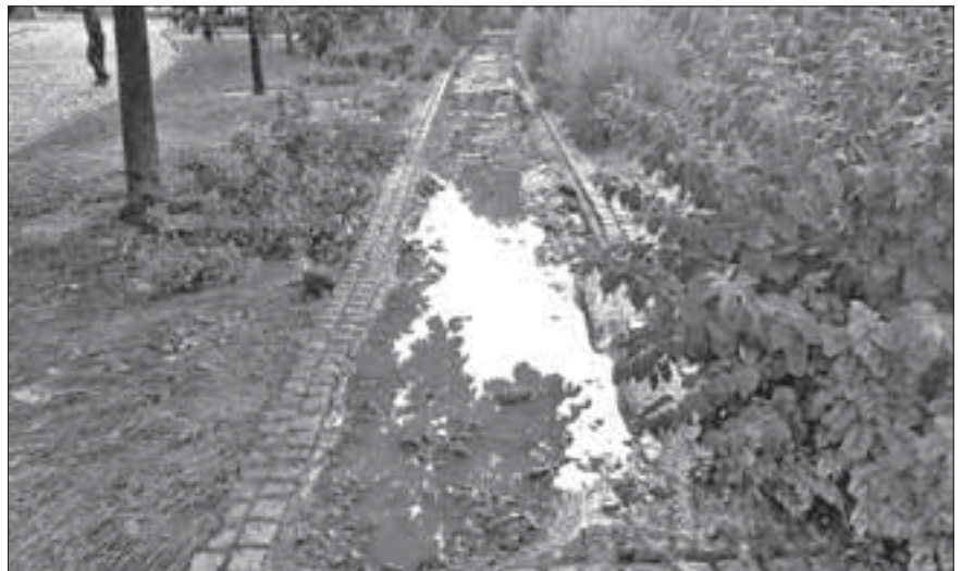
Hirschfelde. Ehemaliger Gehweg in der Akazienallee.
