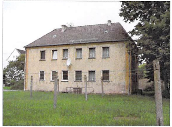
Wesendahler Straße 10: Bei den meisten Gebäuden wurden die ursprünglichen Fenster ersetzt.
