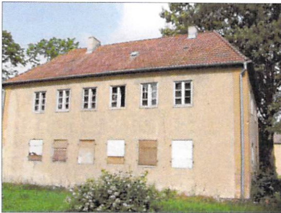
Wegendorfer Straße 505: Die ursprünglichen Fensterformate und -gliederungen sind hier noch erhalten
