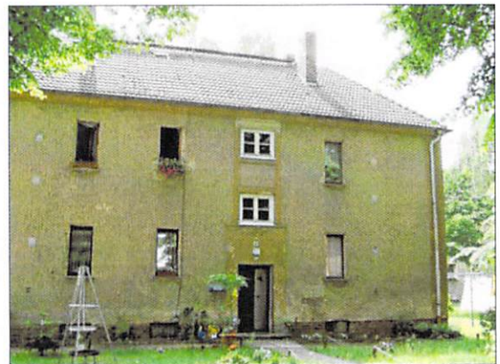
Wesendahler Straße 19: Die asymmetrisch in der Fassade angeordnete Eingangstür ist charakteristisch für die Gebäude des Typs 1.
