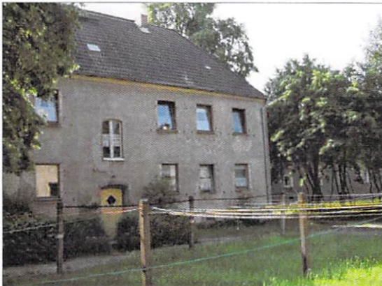
Wesendahler Straße 21: Tür und Fenster des Treppenhauses weisen noch die ursprüngliche Gestaltung mit bogenförmigen Abschluss auf.
