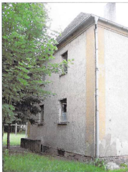
Wesendahler Straße 10: Typische Fassadengliederung des Typs 1 mit Ecklisenen, Dachgesims und Sockel aus Sichtmauerwerk.
