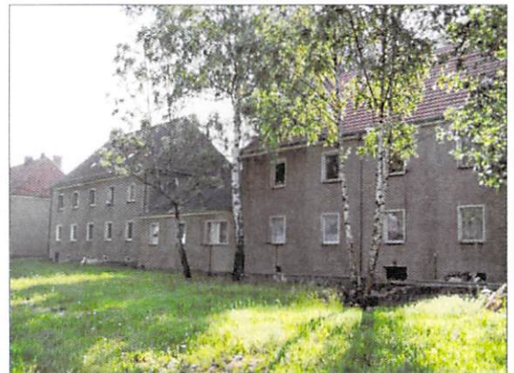
Der nachträglich errichtete Anbau Wesendahler Straße 25 mit abweichendem Fensterformat.
