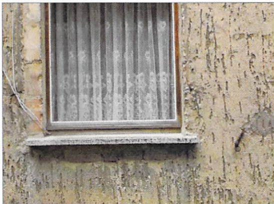
Da das neu eingebaute Fenster schmaler ist, wurde auch die Größe der Fensteröffnung durch eine Steinreihe verringert.
