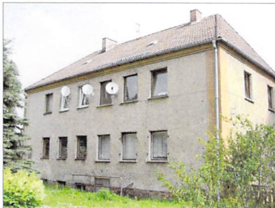
Wesendahler Straße 15: Parabolantennen verunstalten das Fassadenbild.
