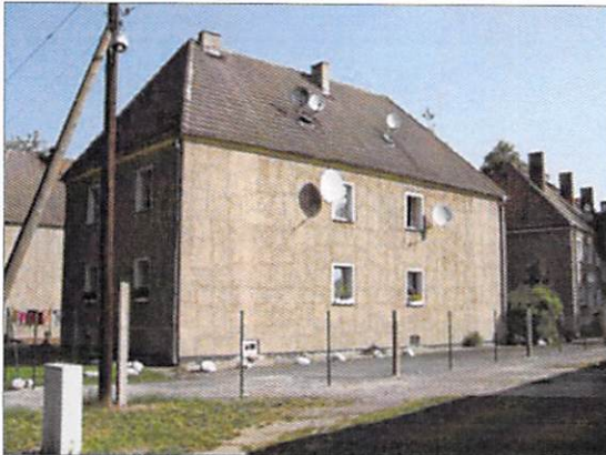
Wegendorfer Straße 85 a: Statt der ursprünglichen vier Fensterachsen sind nur noch zwei vorhanden.
