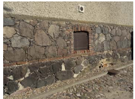
Ausbildung des Sockels durch Materialwechsel
